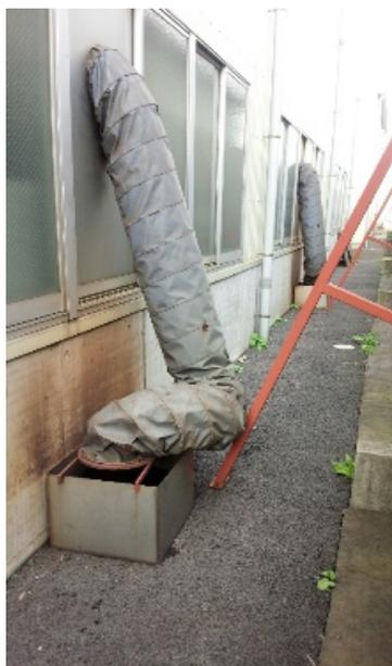
排気ファンとして軸流ファンを使用していたがダクトの圧力損失が大きく有効な風量が得られていなかった。
